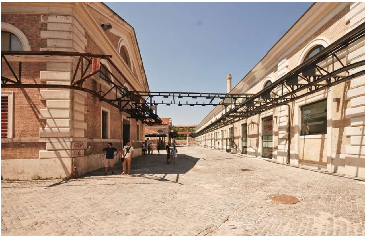
Dipartimento di Architettura, ex Mattatoio di Testaccio
